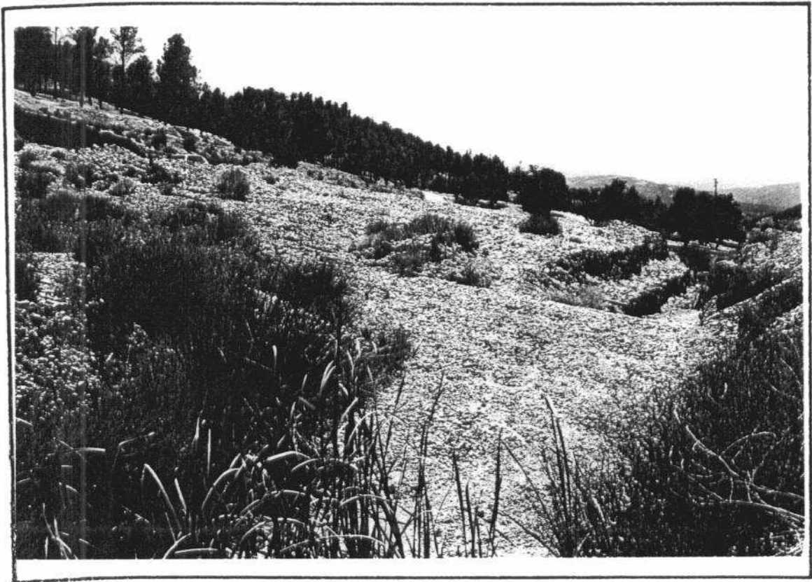
F-4.- ESTADO DEL CANAL DE ENTRADA A LOS DISPOSITIVOS DE INFILTRACION
