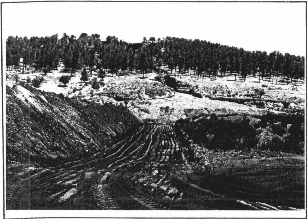
F-6.- COMIENZO DE LA CONSTRUCCION DE LAS TRES NUEVAS BALSAS
